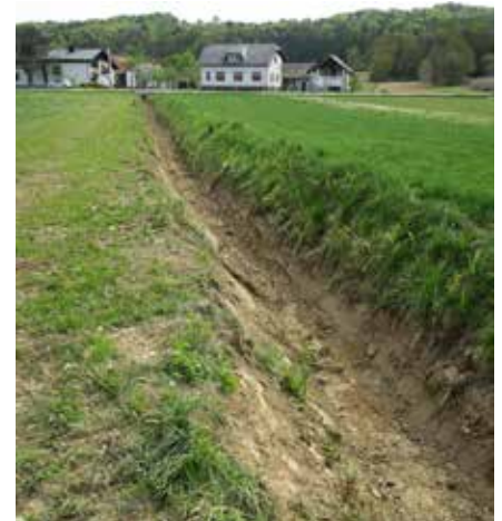
Izkop jarka v Motovilci h.št. 62
