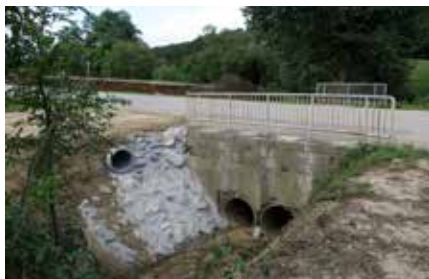
Sanacija mostu in izgradnja propusta Kovačevci
