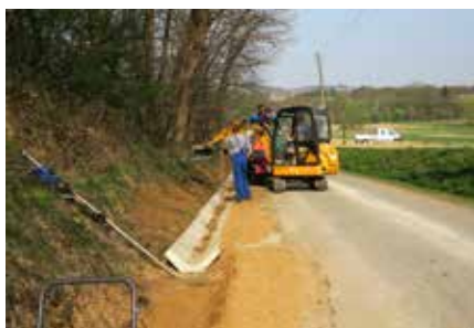
Polaganje kanalet Motovilci – naši pridni delavci Režijski obrat Občine Grad
